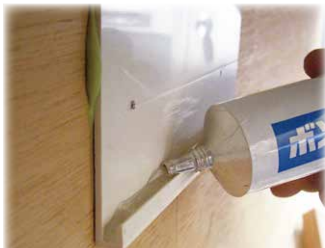
①壁面側 雨樋用ボンドの塗布
