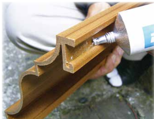
②天井側 雨樋用ボンドの塗布
